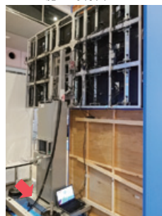
RS-02 施工時背面
