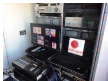
映像・音響機器を内部に装備。
